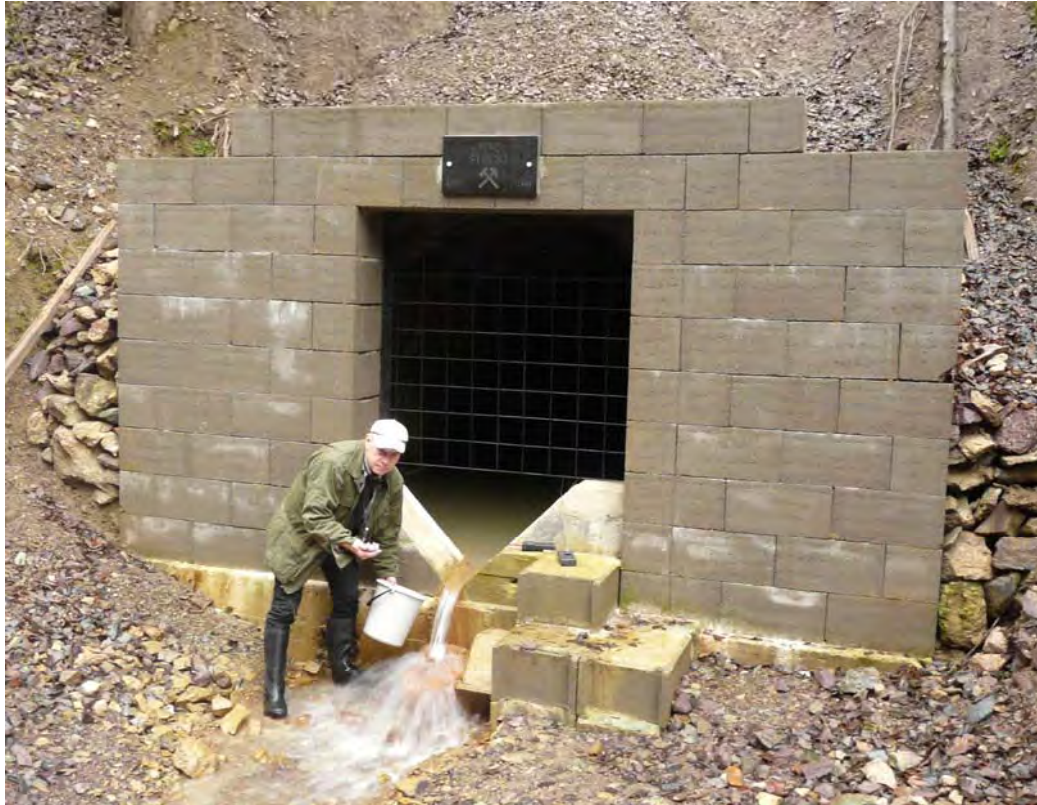
Obr.2.4.80: Ústie Novej štôlne s upraveným portálom po poslednom priedave. (foto P. Bajtoš, 8.12.2009)
