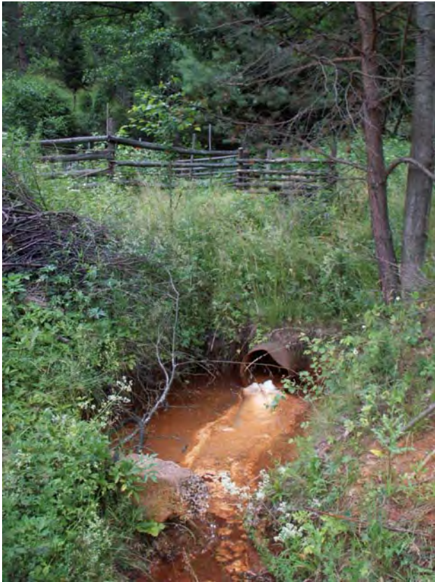
Obr. 70 (vľavo): Lokalita Smolník. Drenáž z odkaliska Smolnícka Huta – spodný výpusť Obr. 71: Lokalita Smolník. Drenáž z odkaliska Smolnícka Huta – horný výpusť. Foto: P. Bajtoš, 30.6.2008
