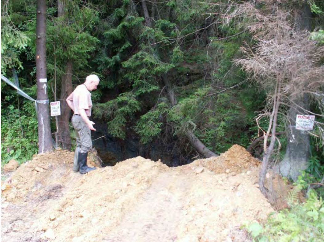
Obr. 63: Lokalita Smolník. Nový zával pri ceste nad odkaliskom likvidovaný zasypávaním. Foto: P. Bajtoš, 30.6.2008
