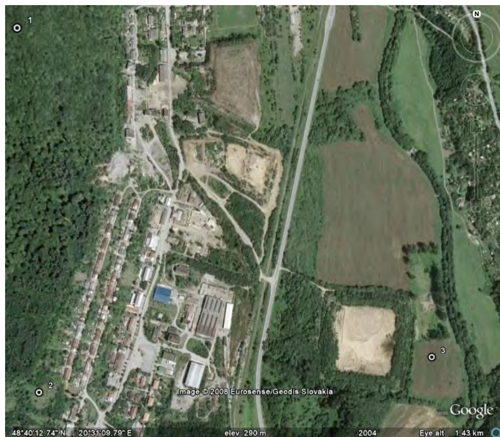
Obr. 34: Lokalita Rožňava. Nadabula – areál bane Sadlovský s haldami a depóniami kalu. Zdroj: Google Earth, satelitná snímka z roku 2004
