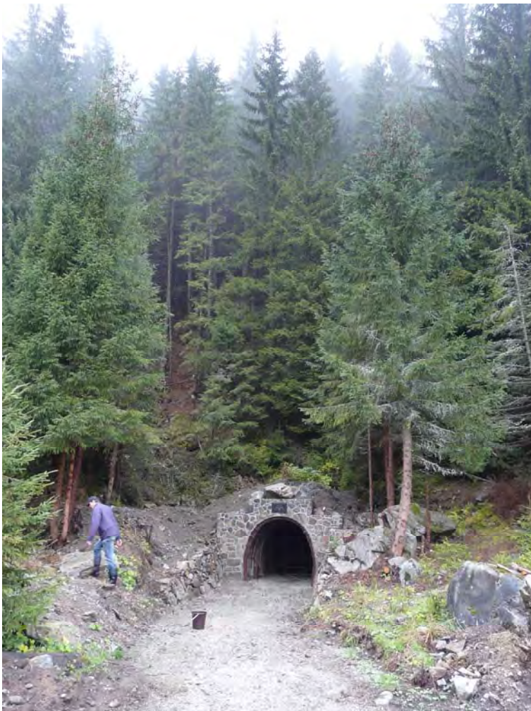
Obr. 88: Lokalita Dúbrava. Ústie a portál štôlne Samuel. Foto: P. Bajtoš, 3.10.2008
