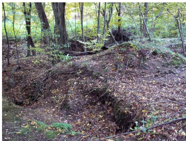
Obr. 2.4.17: Zavalené ústie Ryhovej štôlnie (foto Záhorová, 2009)
