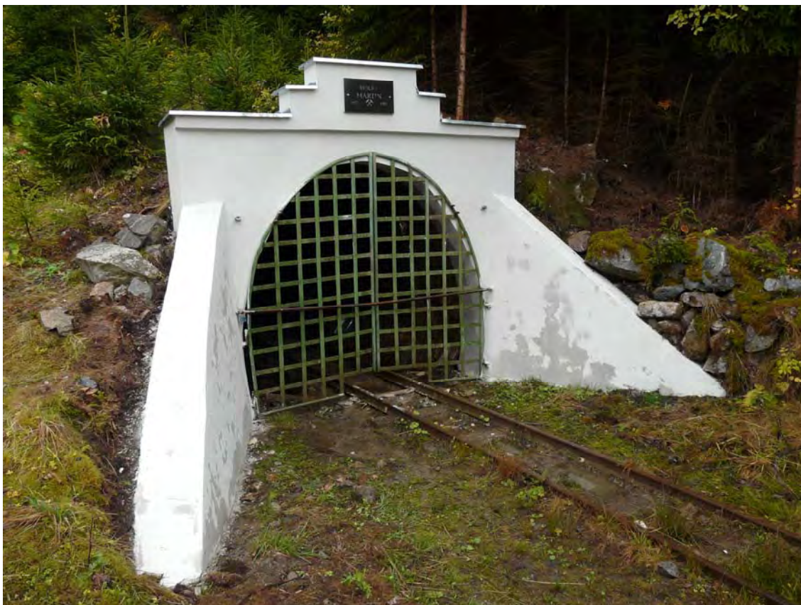
Obr. 83: Lokalita Dúbrava. Portál štôlne Martin. Foto: P. Bajtoš, 3.10.2008
