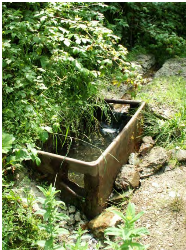
Obr. 45: Lokalita Slovinky. Priesak spod starého odkaliska č.2 zvedený rigolom do banského vozíka Foto: P. Bajtoš, 26.6.2008
