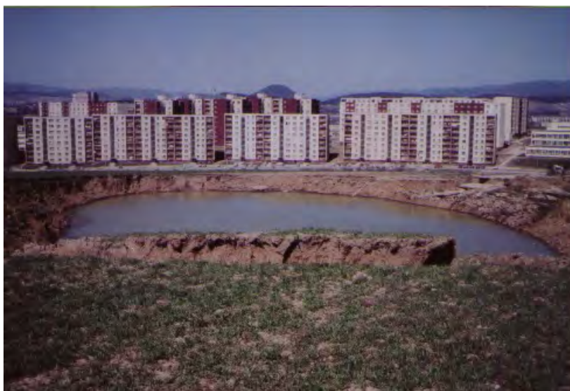
Obr. 2.4.118: Prepadlisko v lúhovacom poli ložiska Prešov - Solivar (apríl 1988)
