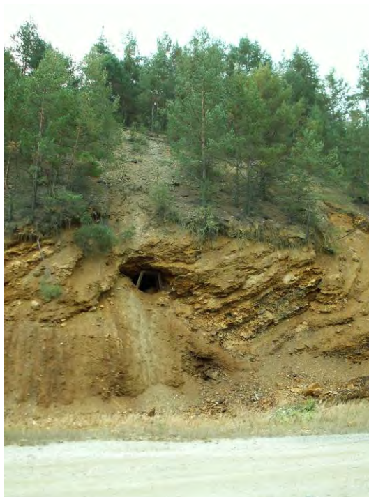
Obr. 2.4.76: Odrez vo svahu odkryl starú štôľňu, nad ňou sa nachádza halda (foto Záhorová, 2009)
