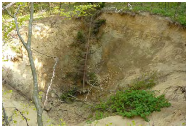
Obr. 2.4.84: Zával nad ústím Novej štôlne po prvom prievale. (foto P. Bajtoš, 3.5.2009)
