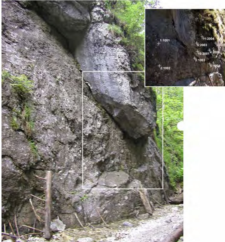
Obr. 2.1.171: Potenciálne nestabilný skalný blok nad turistickým chodníkom v doline Suchá Belá. V detaile je rozmiestnenie vzťažných a pozorovaných bodov pre fotogrametrické snímokovanie (foto P. Bartoš, 2006)
