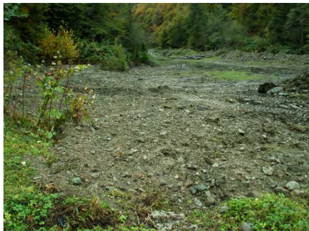
Obr. 2.4.55: K opätovnému prehĺbeniu závalu došlo i v blízkosti jamy Adam Eva, ktorý bol opätovne sanovaný zavezením (foto Záhorová, 2009)
