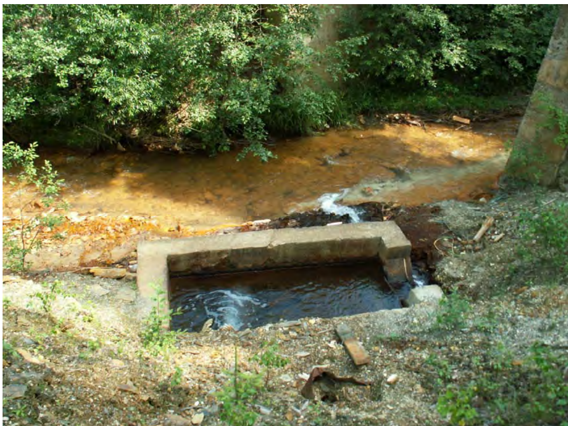
Obr. 52: Lokalita Smolník. Merný objekt Sm5 – výusť odtoku zo šachty Pech, pri Smolníckom potoku. Foto: P. Bajtoš, 30.6.2008
