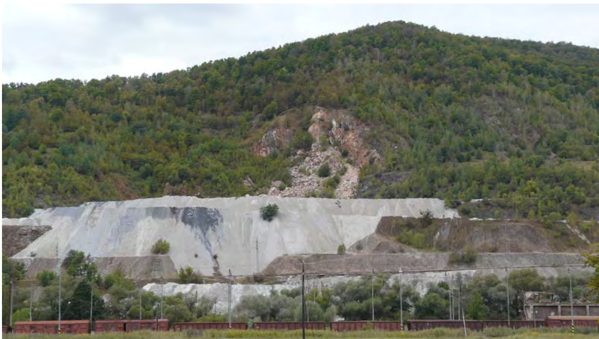
Obr. 31: Lokalita Lubeník – pohľad z obce Lubeník haldy pri areále závodu. Foto – P. Bajtoš, 18.9.2008
