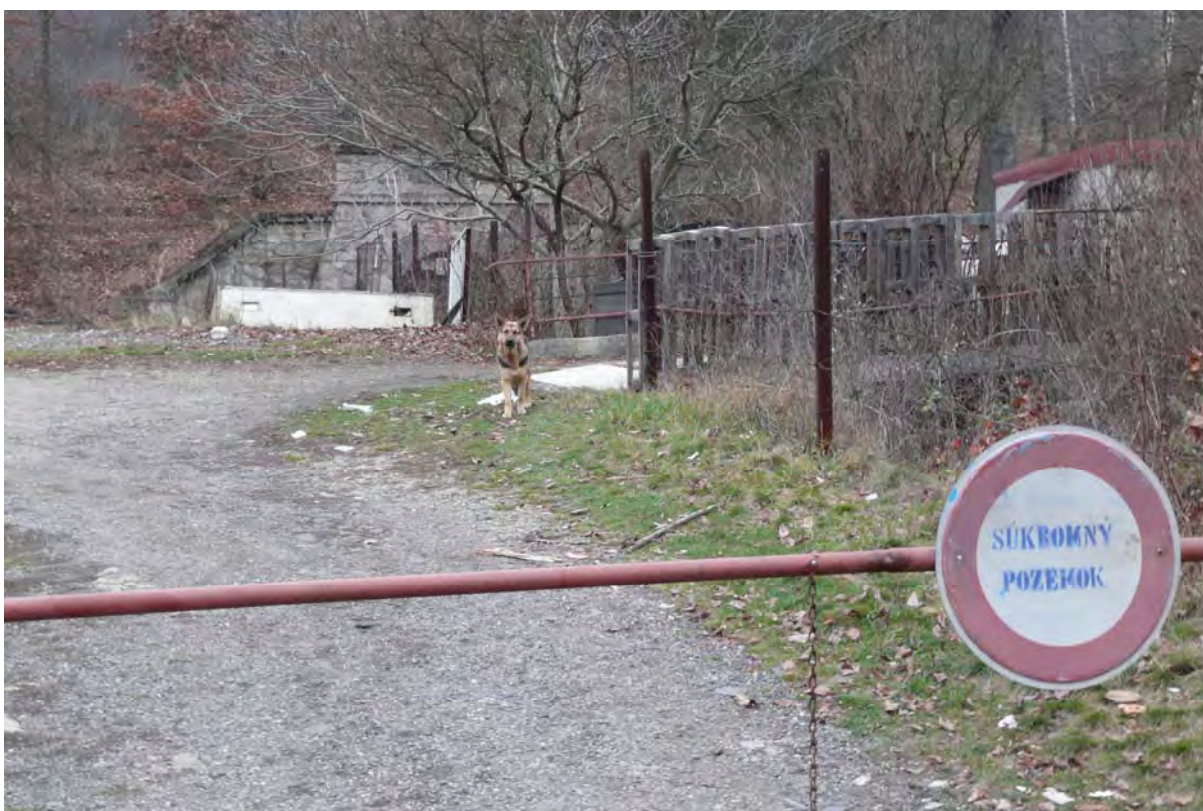
Obr. 80: Lokalita Kremnica. Prístup k ústiu Hlavnej dedičnej štôlny. Foto – P. Bajtoš, 13.11.2008
