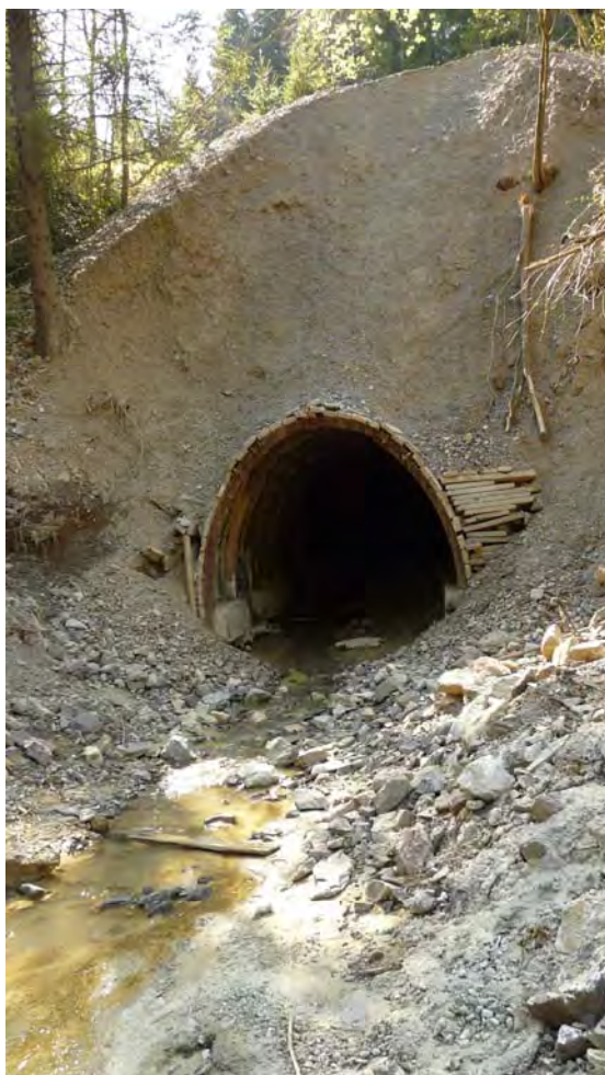
Obr. 106: Teplička nad Hornádom – následky prievalu banskej vody z Novej štólne. Ústie Novej štólne po rekonštrukčných prácach. Foto: P. Bajtoš, 3.5.2009
