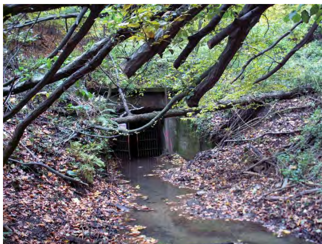
Obr. 2.4.19: Pyritová štôľňa so zátrhmi nad portálom (foto Záhorová, 2009)
