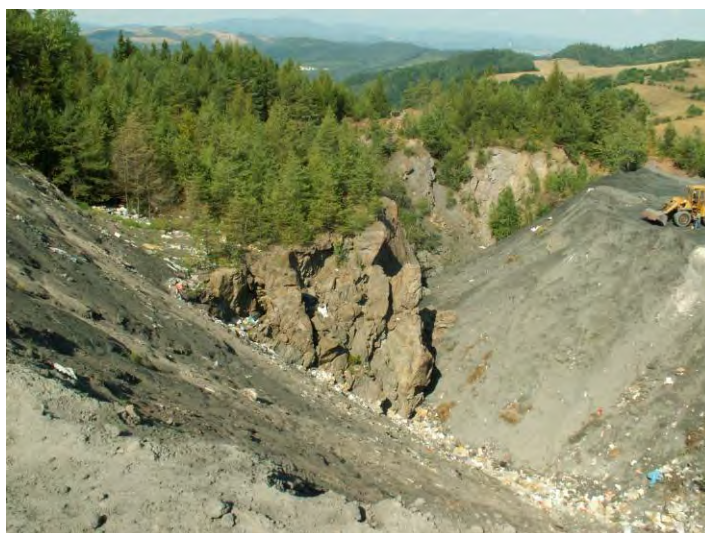
Obr. 2.4.28: Postupné zasypávanie závalu „Baniská“ (foto Záhorová, 2007)
