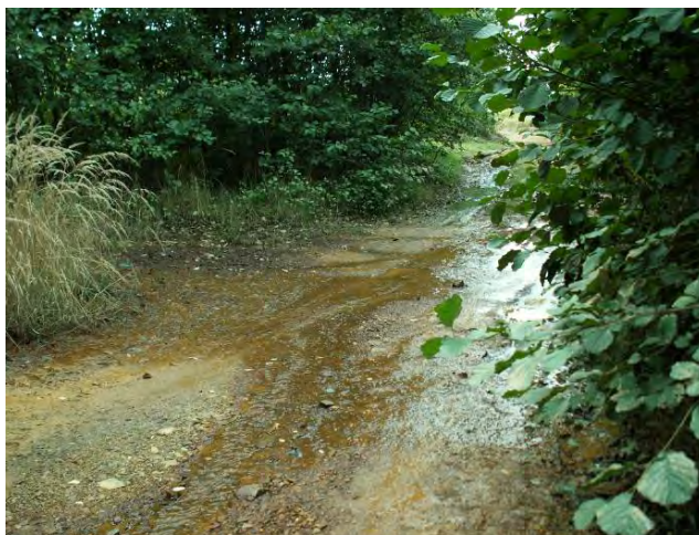
Obr. 2.4.61: Zamokrenie na príjazdovej ceste pod odvalom Dopravného prekopu (foto Záhorová, 2009)
