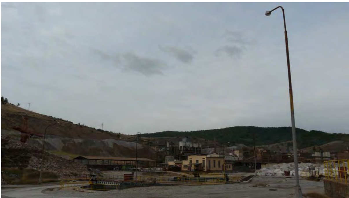
Obr. 20: Loklita Lubeník. Pohľad od ČOV na areál úpravne. Foto – P. Bajtoš, 18.9.2008
