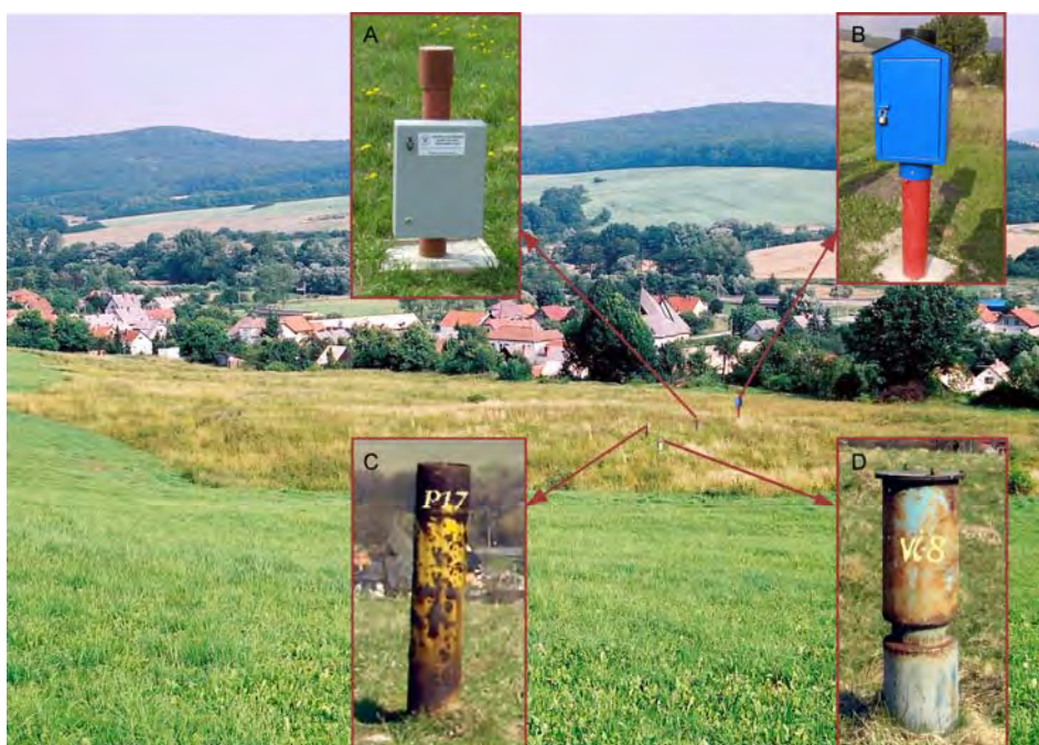
Obr. 2.1.4: Zosuv nad obcou Veľká Čausa – pohľad od odľučnej oblasti na teleso zosuvu s niektorými monitorovacími objektmi A – kontinuálny inklinometer umiestnený vo vrte KI-1, B – automatický hladinomer so systémom včasného varovania umiestnený vo vrte AH-1, C – geodetický bod P17, D – automatický hladinomer umiestnený v inklinometrickom vrte VČ-8 (foto P. Ondrejka, 2009)
