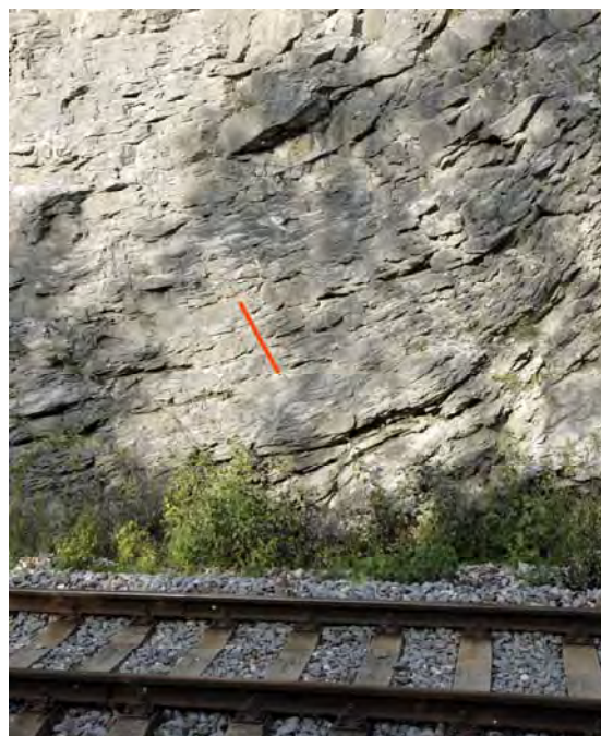
Obr. 2.1.148: Umiestnenie stanoviska na meranie mikromorfologických zmien povrchu odkrytého zárezu železnice pri obci Jakub. Červenou líniou je zvýraznené stanovisko umiestnenia meradla morfologických zmien (foto M. Brček, 2009)
