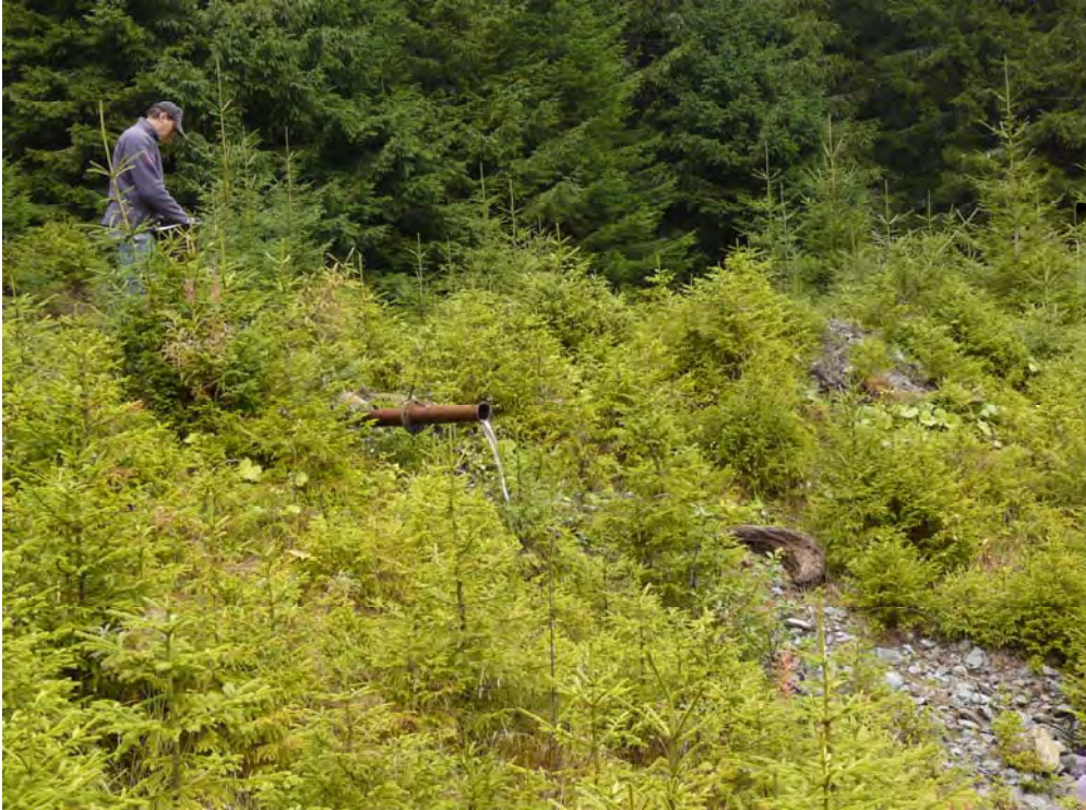
Obr. 87: Lokalita Dúbrava. Výtok banskej vody zo štôlne Samuel je vyvedený potrubím na horný okraj haldy kde voľne vyteká na jej svah a vsakuje doň.. Foto: P. Bajtoš, 3.10.2008
