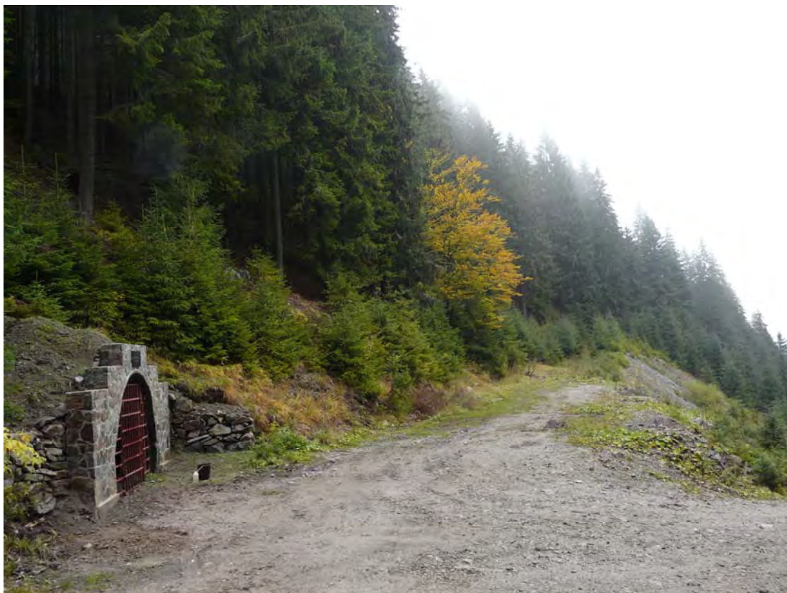
Obr. 89: Lokalita Dúbrava. Ústie a portál štólne Rakytová, pred ňou rekultivovaná halda. Foto: P. Bajtoš, 3.10.2008
