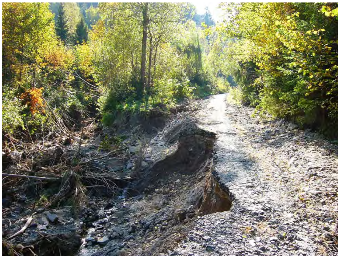
Obr. 102: Teplička nad Hornádom – následky prievahu banskej vody z Novej štôlne. Erózia pôvodného koryta potoka pod štôľňou a deštrukcia vozovky. Foto: P. Baláž, 2.10.2008
