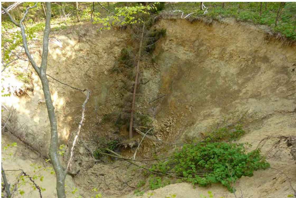
Obr. 110: Teplička nad Hornádom – následky prievahu banskej vody z Novej štôlne. Kráterovitý zával nad Novou štôľňou – pohľad zo Z. Priemer krátera 15 m, hĺbka 8-10 m. Foto: P. Bajtoš, 3.5.2009
