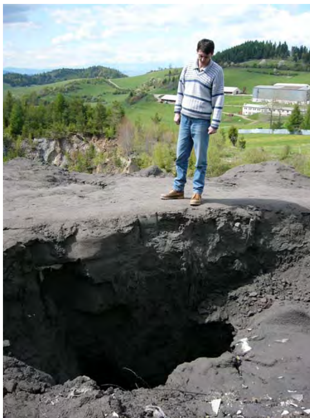
Obr. 38: Lokalita Rudňany. Závalové pásmo žily Droždiak pri Poráči zavázané elektrárenským popolčekom. Foto: P. Baláž, 12.5.2005
