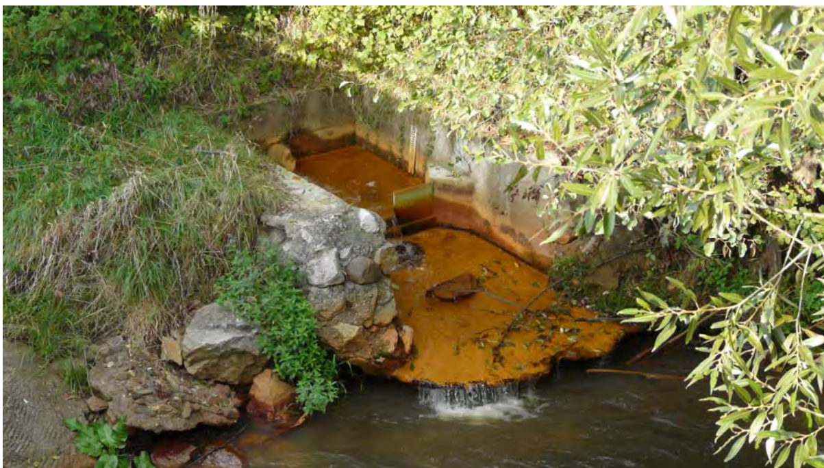
Obr. 76: Lokalita Rožňava. Výúst odpadového potrubia z Dopravného prekopy s merným prahom do rieky Slaná. Foto P. Bajtoš, 18.9.2008
