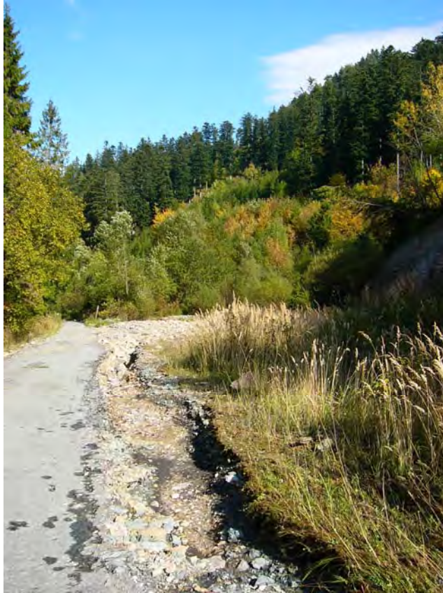
Obr. 99: Teplička nad Hornádom – následky prievalu banskej vody z Novej štôlne. Erózia dna doliny pozdĺž asfaltovej cesty a nižšie položenej haldy (na pravej strane). Foto: P. Baláž, 2.10.2008
