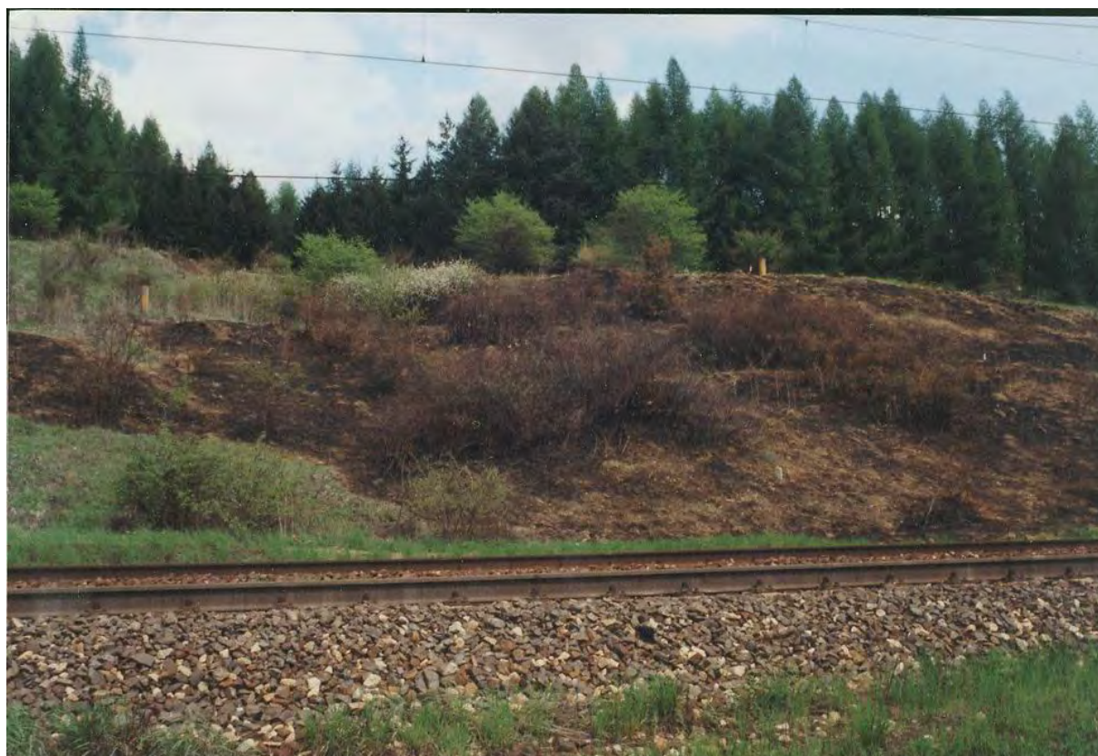
Obr. 2.1.56: Zosuv Okoličné – pohľad na čelo akumuláčnej časti zosuvu nachádzajúce sa na kontakte so železničnou traťou (foto P. Wagner, 2002)
