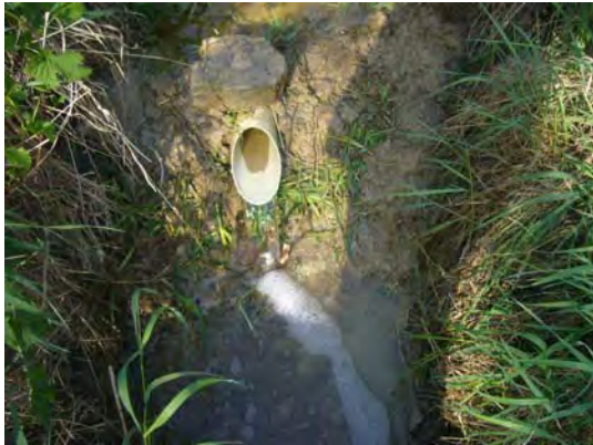
Obr. 2.3.17: Výtok z čela skládky, meranie prietoku
