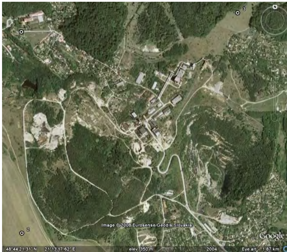
Obr. 12: Ložisko Košice. Areál ťažobno – spracovateľského závodu s jamovým lomom a depóniami odpadu, v SZ časti so zatopeným závalom. Zdroj: Google Earth, satelitná snímka z roku 2004
