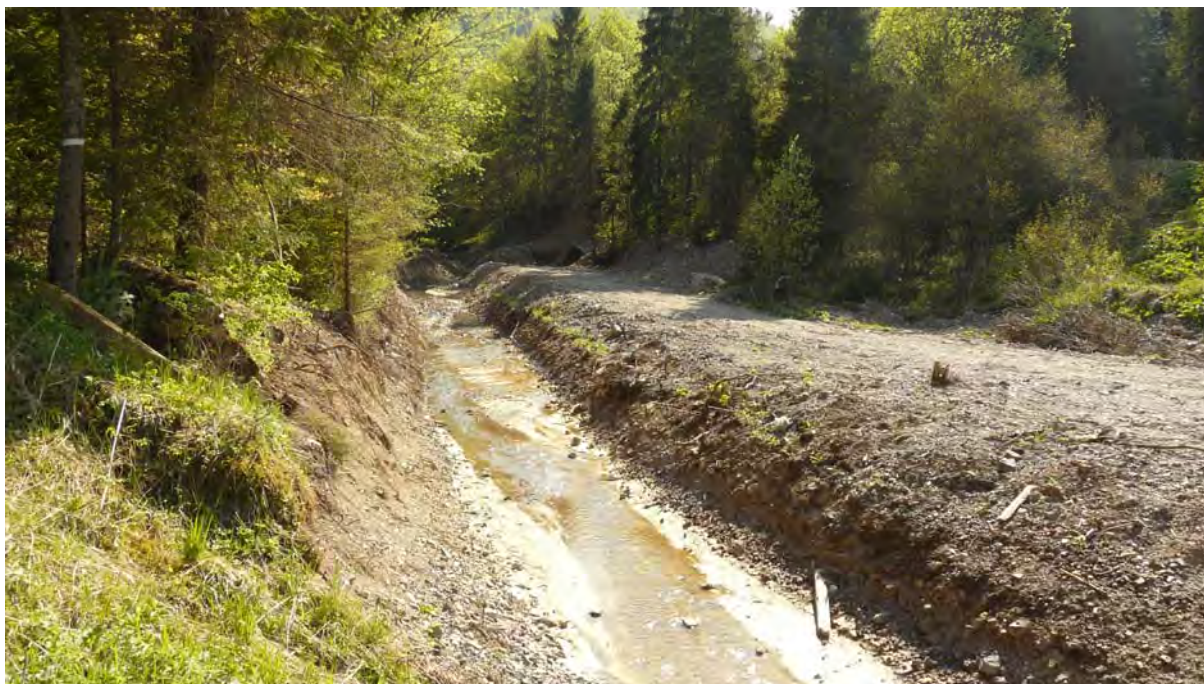
Obr. 107: Teplička nad Hornádom – následky prievahu banskej vody z Novej štôlne. Ústie Novej štôlne a odtokové koryto po rekonštrukčných prácach. Foto: P. Bajtoš, 3.5.2009
