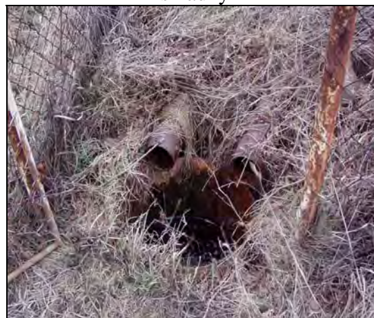
Obr. 2.3.29: Vpust drénáže v čele skládky
