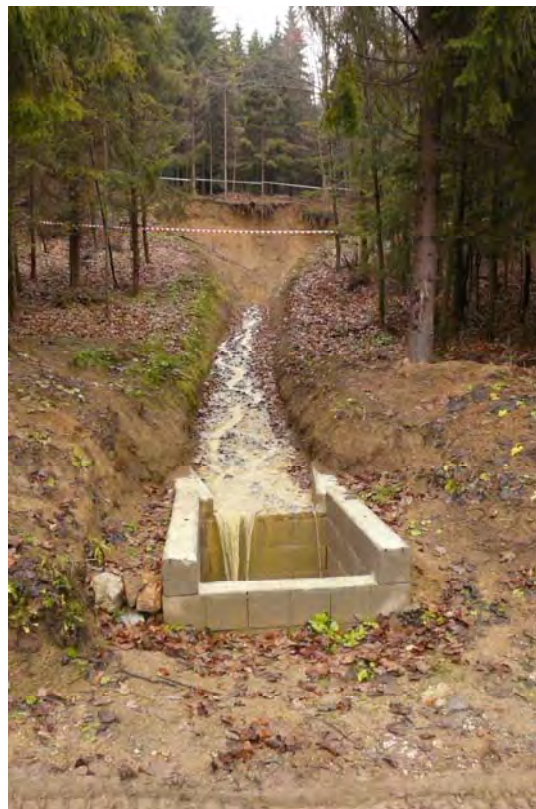
Obr. 2.4.81: Zával nad Novou štôľňou s prelivom banskej vody. (foto P. Bajtoš, 8.12.2009)
