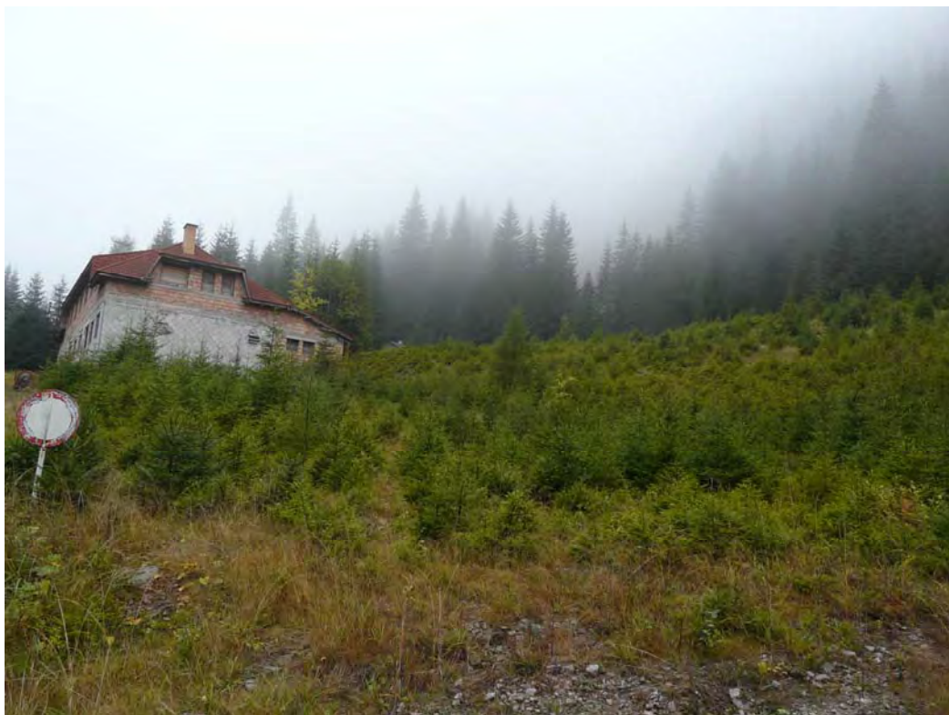
Obr. 86: Lokalita Dúbrava. Rekultivovaná halda pod štôľňou Samuel. Výtok banskej vody z tejto štôlny je vyvedený potrubím na horný okraj haldy kde voľne vyteká na jej svah a vsakuje doň. Foto: P. Bajtoš, 3.10.2008
