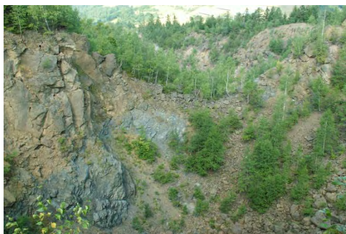
Obr. 2.4.26: Okraje závalu sú zasutené bez možnosti bezpečného prístupu (foto Záhorová, 2007)
