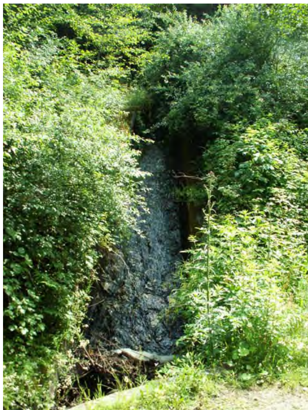
Obr. 46: Lokalita Slovinky. Priesak spod odkaliska č.3 zvedený betónovým žľabom so strmým spádom do hlavného odvodňovacieho rigolu. Foto: P. Bajtoš, 26.6.2008
