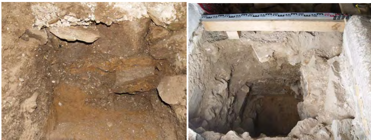
Obr. 2.6.64: a) Detail dna šachtice pod jedným z pilierov lode kostola sv. Jakuba, b) kamenný základ, pod ním deluviálne hliny (foto Baxa, 2009)
