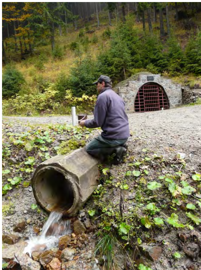
Obr. 91: Lokalita Dúbrava. Ústie a portál štólne Rakytová, pred ňou odpadové potrubie s výtokom banskej vody do potoka. Foto: P. Bajtoš, 3.10.2008
