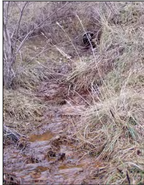
Obr. 2.3.29: Vpust drénáže v čele skládky
