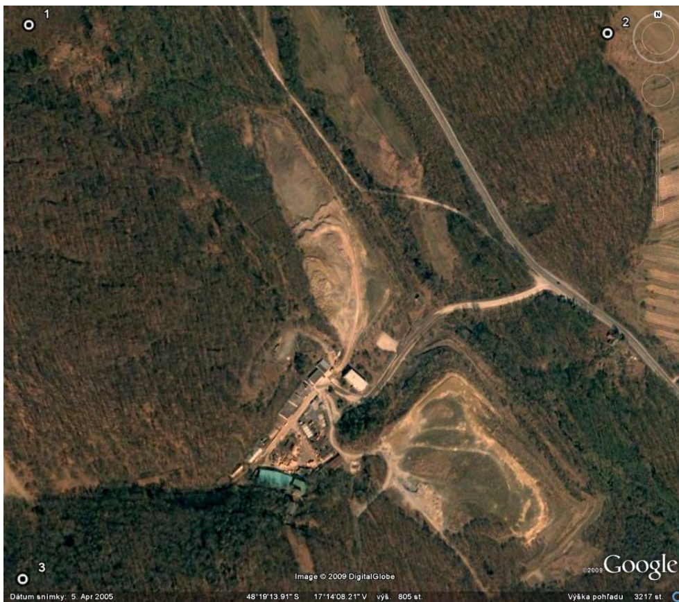
Obr. 45: Lokalita Pezinok. Areál ťažobno – spracovateľského závodu s odkaliskami. Zdroj: Google Earth, satelitná snímka z roku 2004
