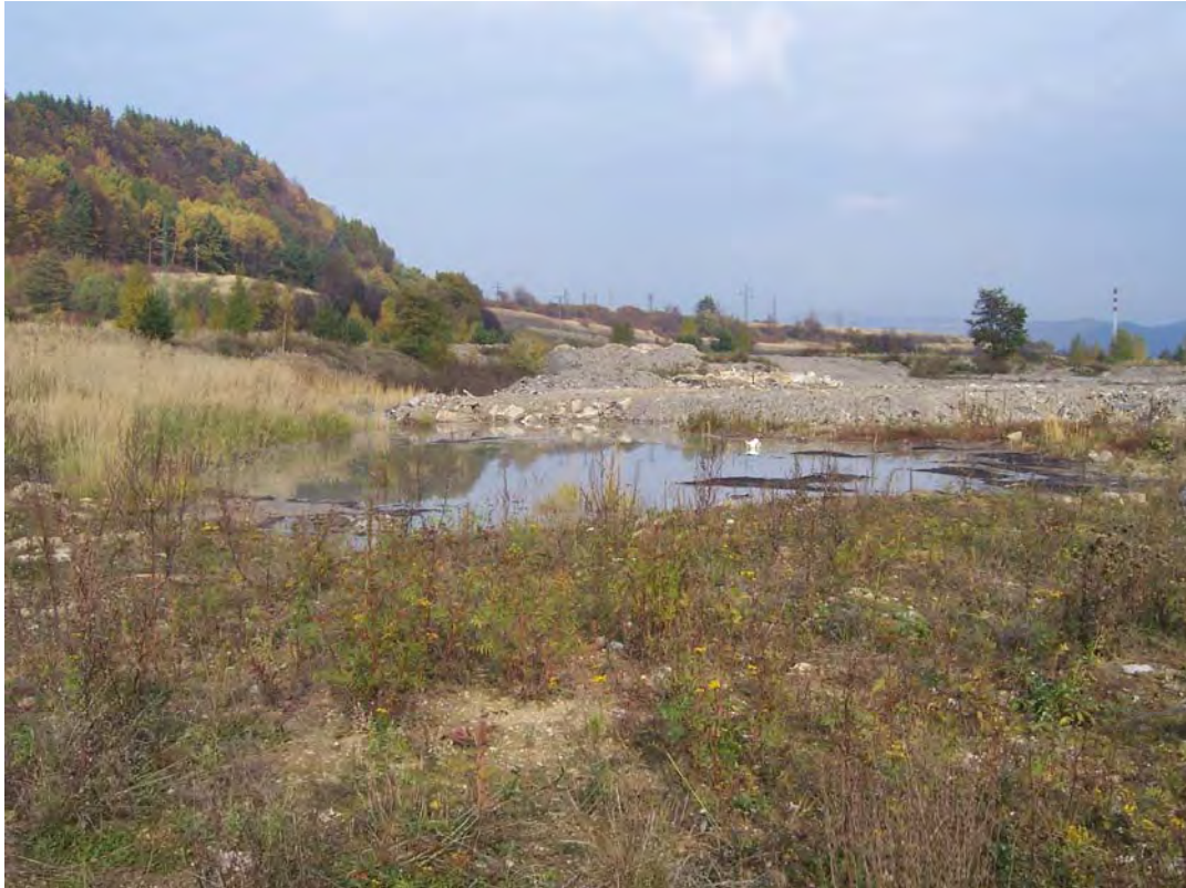
Obr. 2.1.161: Ukladanie nevhodných materiálov na západnom okraji násypu (neďaleko od vtokového objektu Nepomenovaného potoka) a vytváranie „jazier“ neznámych viskózných látok (foto Z. Nagy, 2008)
