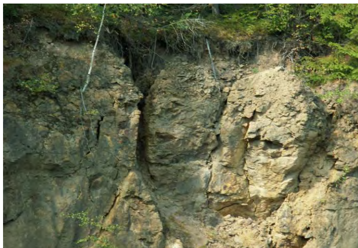
Obr. 2.4.27: Detail aktívnej ťahovo-poklesovej trhliny (foto Záhorová, 2007)
