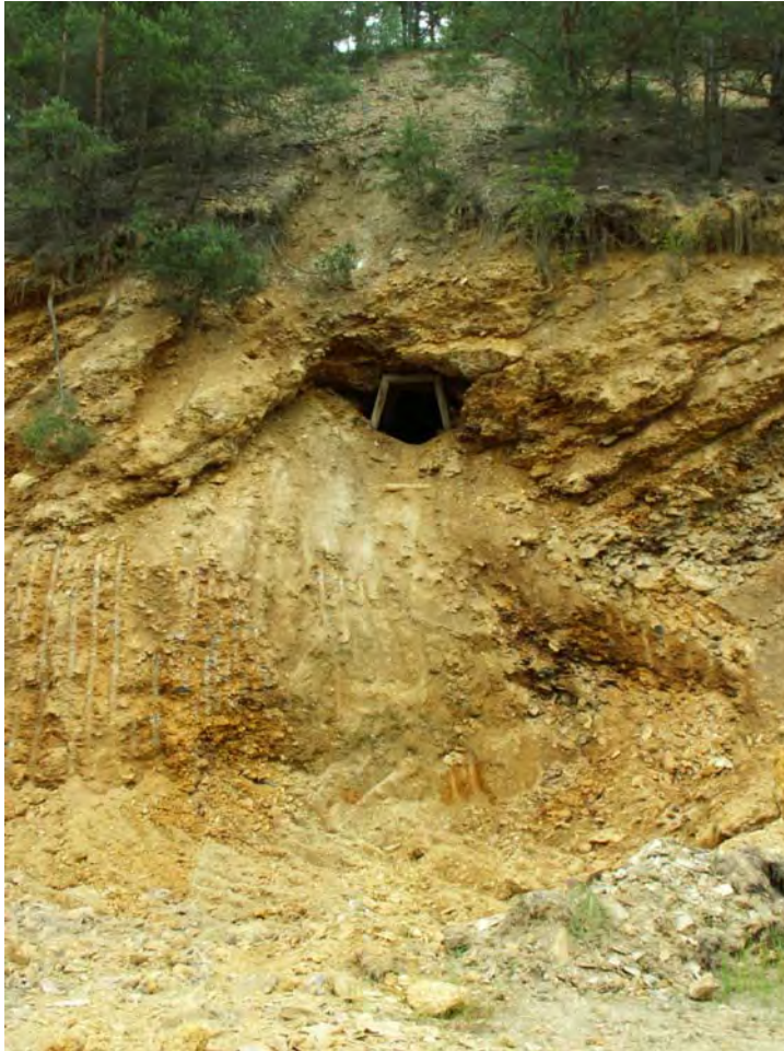
Obr. 61: Lokalita Smolník. Štôľňa v záreze do svahu pri ceste na odkalisko zo závodu v Smolníckej Hute. Foto: P. Bajtoš, 30.6.2008
