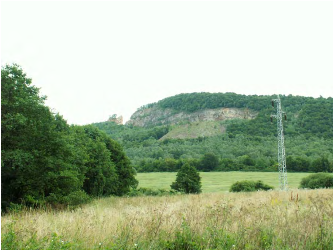
Obr. 9: Lokalita Jelšava. Lomová ťažba ložiska Dúbravský masív – pohľad od južného okraja Magnezitoviec. Foto: P. Baláž, 15.7.2008
