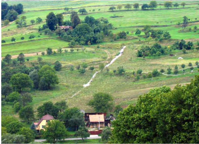
Obr. 2.1.87: Pohľad na sanovaný zosuvný svah na SZ okraji obce Kvašov. V centrálnej časti je línia hlavného odvodňovacieho drénu, zasypaného kamennou drvinou (foto P. Ondrejka, 2007)
