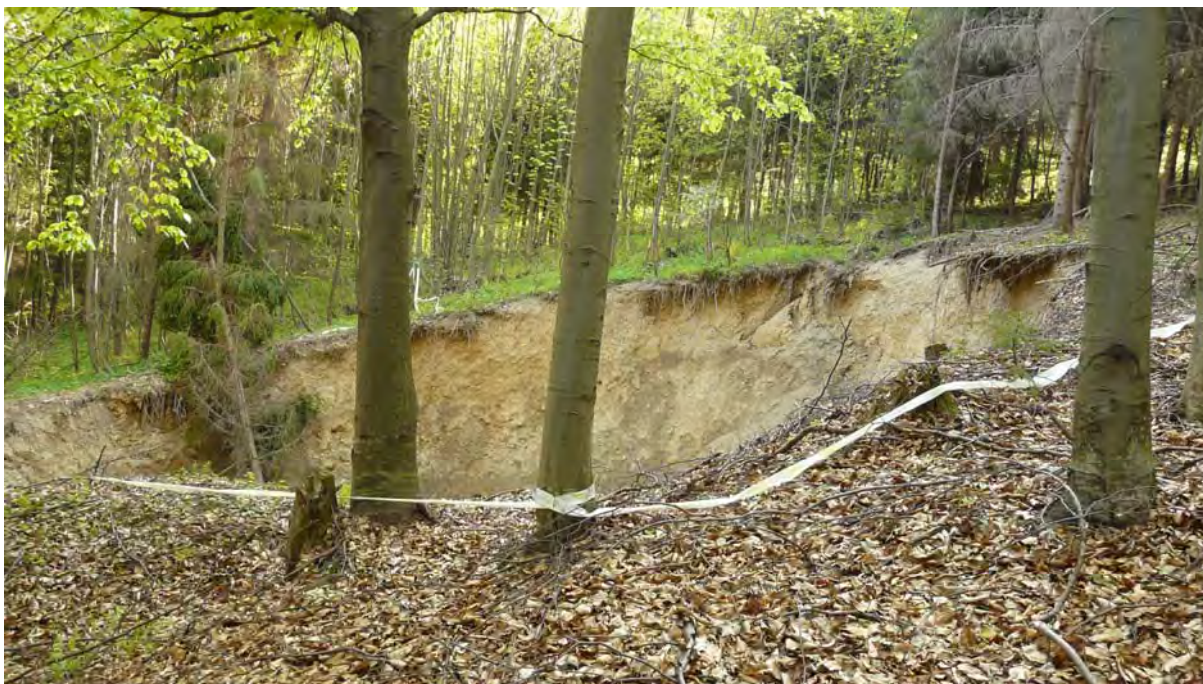
Obr. 111: Teplička nad Hornádom – následky prievahu banskej vody z Novej štólne. Kráterový zával nad Novou štôľňou – pohľad zo S. Priemer krátera 15 m, hĺbka 8-10 m. Foto: P. Bajtoš, 3.5.2009
