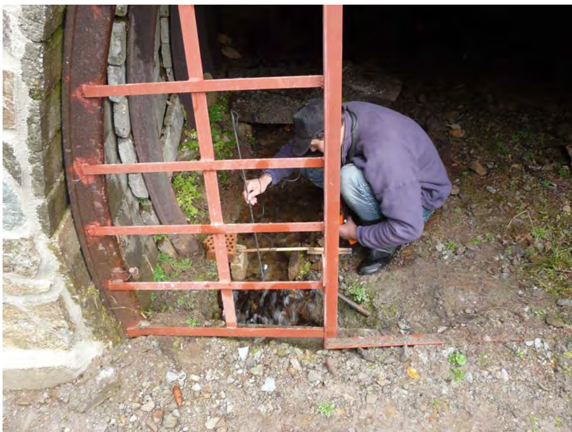
Obr. 90: Lokalita Dúbrava. Hydrometrické meranie prietoku banskej vody v ústí štólne Rakytová. Foto: P. Bajtoš, 3.10.2008
