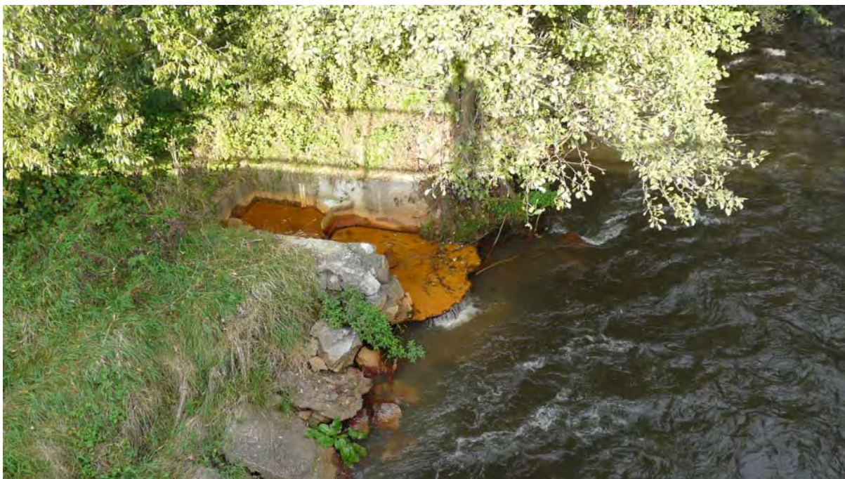
Obr. 77: Lokalita Rožňava. Výúst' odpadového potrubia z Dopravného prekopy s merným prahom do rieky Slaná, pohľad z mosta. Foto P. Bajtoš, 18.9.2008
