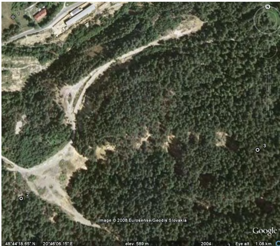
Obr. 28: Lokalita Smolník. Pásmo závalov nad podrúbaným územím. Zdroj: Google Earth, satelitná snímka z roku 2004
