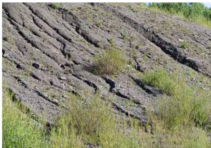
Obr. 2.4.32: Erózia svahu haldy Rudňany - Zimné (foto Záhorová, 2007)
