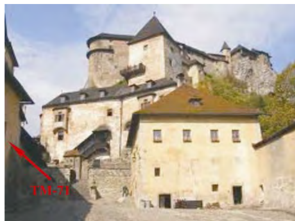
Obr. 2.6.67: Pozícia dilatometra TM 71
