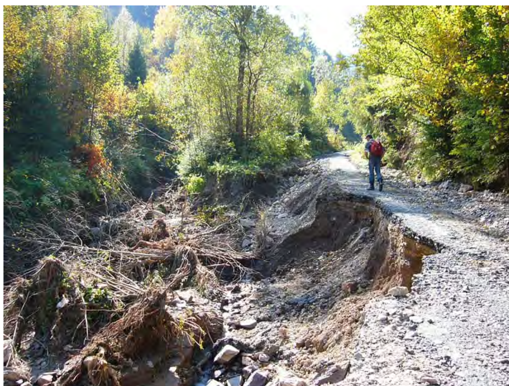
Obr. 2.4.79: Erózia údolia a cesty pod ústím Novej štôlny po prvom prievale (foto P. Baláž, 2.10.2008)
