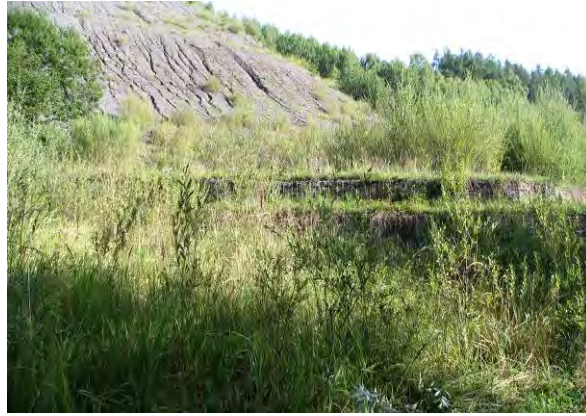
Obr. 2.4.33: Päta haldy Rudňany - Zimné je stabilizovaná, ale povrch haldy nie je chránený pred eróziou (foto Záhorová, 2007)
