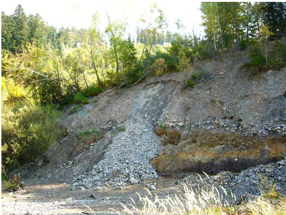
Obr. 101: Teplička nad Hornádom – následky prievahu banskej vody z Novej štôlne. Erózia haldy lokalizovanej pod štôľňou. Foto: P. Baláž, 2.10.2008
