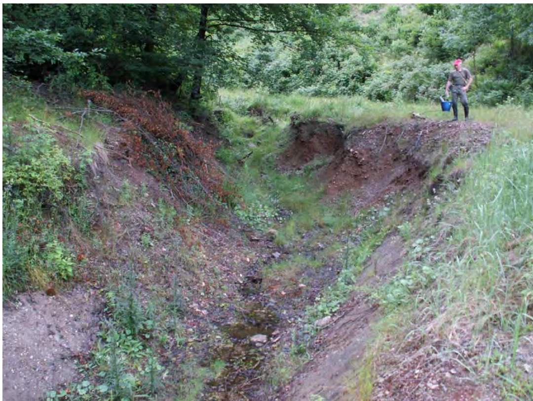
Obr. 43: Lokalita Slovinky. Horný okraj odvodňovacieho rigolu (betónové panely) odkaliska Slovinky je v úrovni kde stojí J. Blahut. Vyššie je neizolované koryto potoka zarezané v materiáli odkaliska. Foto: P. Bajtoš, 26.6.2008
