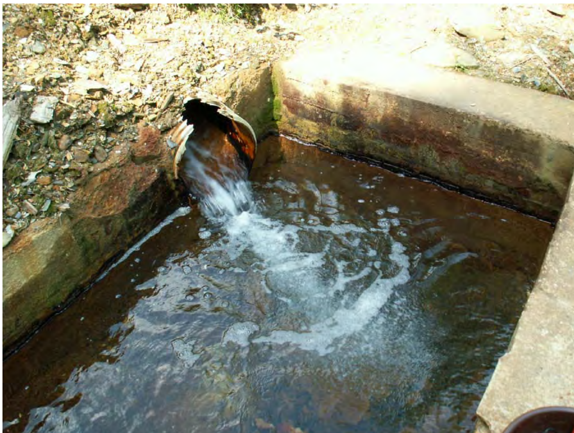
Obr. 55: Lokalita Smolník. Detail merného objektu banskej vody šachty Pech. Foto: P. Bajtoš, 30.6.2008
